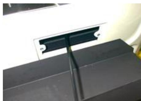
*Figura n°17 - Accessi per la pulizia dello scarico fumi.*
