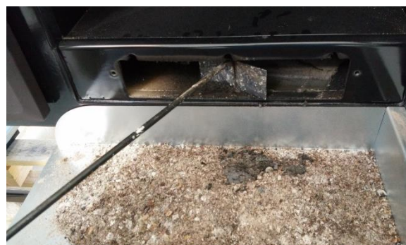
Figure n°24 - Accès pour le nettoyage de la sortie de fumée
