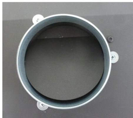
Figure n°7 - Tuyère correctement vissée aux 3 points avec ses rondelles
