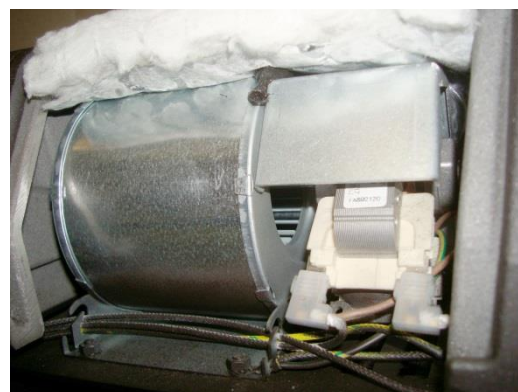
Figure n°28 - Accès aux fans
