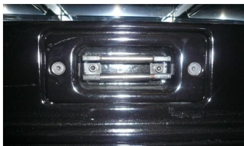
Figura n°30 - Accessi per la pulizia dello scarico fumi.
