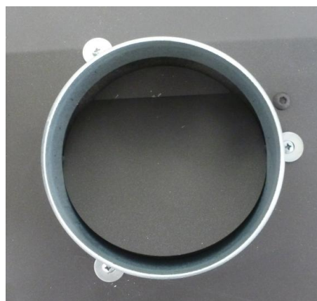
Figura n°7 - Bocchetta correttamente avvitata nei 3 punti con le sue rondelle
