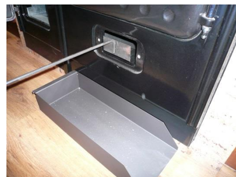
Figura n°19 - Accessi per la pulizia dello scarico fumi.
