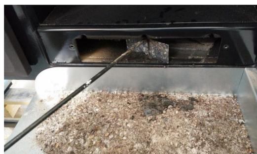
*Figura n°21 - Accessi per la pulizia dello scarico fumi.*
