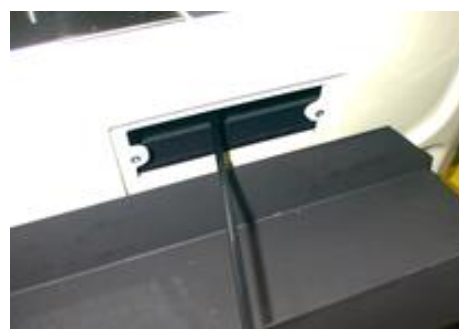
Figura n°18 - Accessi per la pulizia dello scarico fumi.
