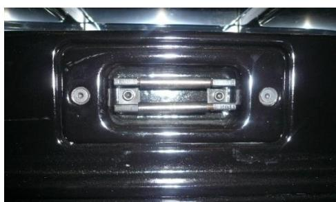
Figura n°32 - Acessos para a limpeza da saída de fumos.
