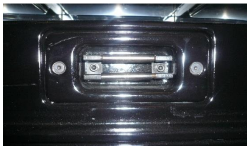
Figura nº32 - Acessos para a limpeza da saída de fumos.
