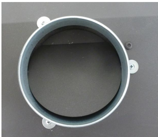
Figura n°7 - Tubagem corretamente aparafusada nos 3 pontos com as suas anilhas
