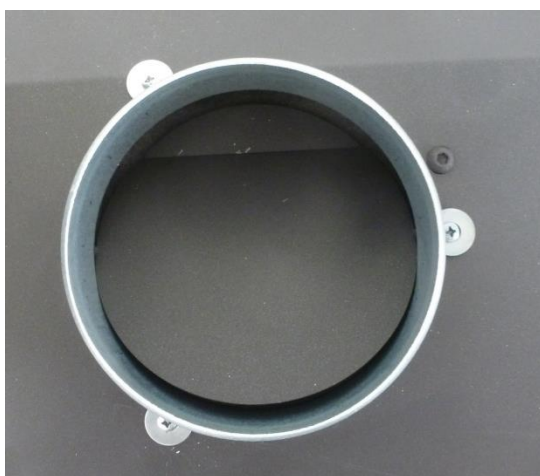
Figura nº8 - Tubagem corretamente aparafusada nos 3 pontos com as suas anilhas
