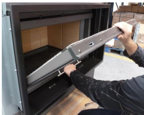
Figura nº38 - Passo intermédio ao rebater
