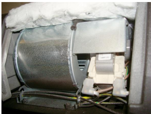
Figura nº28 - Acesso a fã
