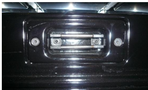
Figura n°17 - Accesos para la limpieza de la salida de humos.
