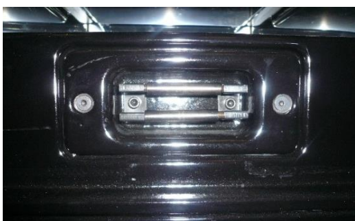
Figura n°25 - Accesos para la limpieza de la salida de humos.
