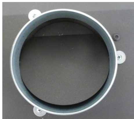
Figura nº9 - Tobera correctamente atornillada en los 3 puntos con sus arandelas
