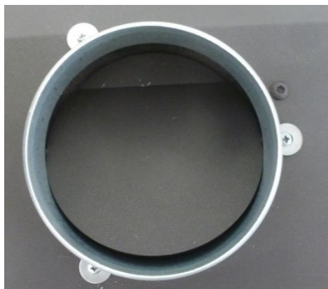
Figura n°9 - Tobera correctamente atornillada en los 3 puntos con sus arandelas
