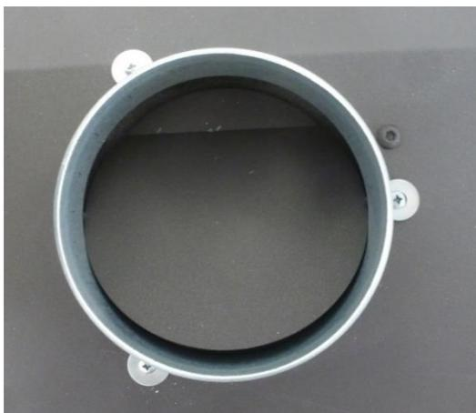
*Figura nº2 - Tobera correctamente atornillada en los 3 puntos con sus arandelas*
