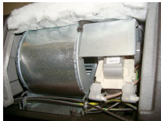
Figura n°29 - Acceso a los ventiladores
