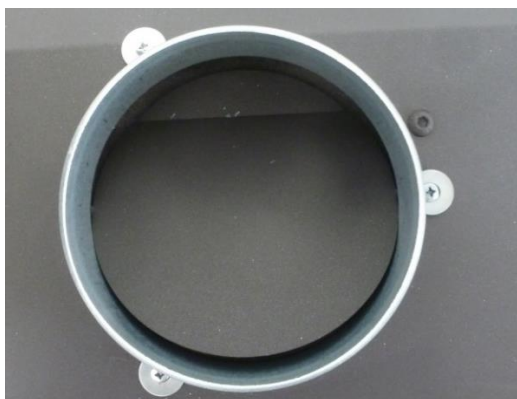
Figura n°8 - Tobera correctamente atornillada en los 3 puntos con sus arandelas
