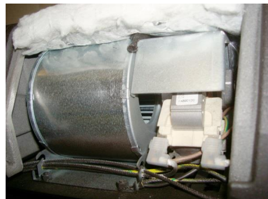
Figura nº28 - Acceso a los ventiladores
