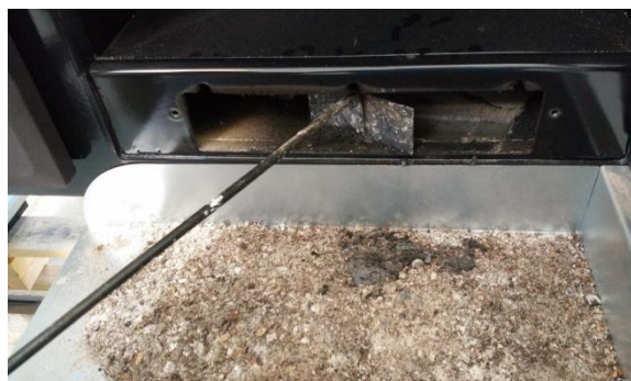
Figura n°22 - Accesos para la limpieza de la salida de humos.
