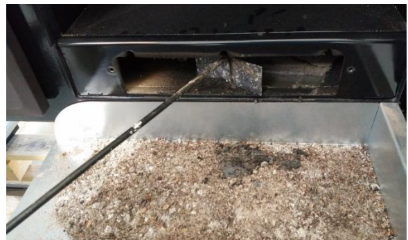
Figura n°21 - Accesos para la limpieza de la salida de humos.
