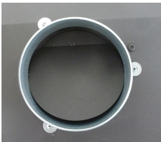
Figura n°8 - Bocchetta correttamente avvitata nei 3 punti con le sue rondelle
