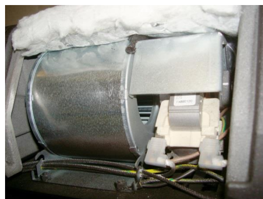
Figura nº28 - Acceso a los ventiladores
